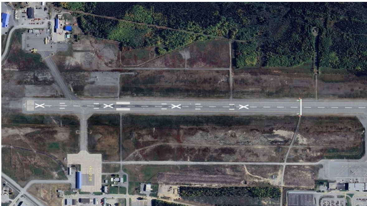
Figure 3. Balisage de zone opérationnelle de piste fermée et de seuil décalé
